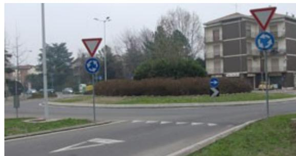
La **Mini Rotatoria**, ha un diametro esterno inferiore ai 24 metri (in genere fino ai 13 m.); presenta un'isola centrale semi-sormontabile o totalmente sormontabile per permettere anche agli autotreni di transitare.
